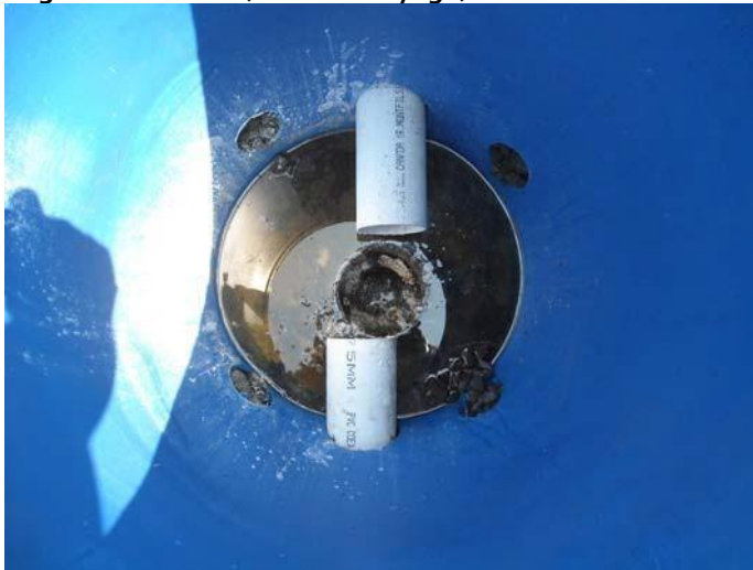
Regard de collecte (avant nettoyage)
